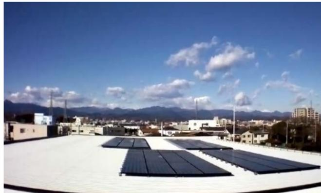
2013年、青梅ガス本社屋上に約12.5kwの太陽光発電システムを設置し発電を開始いたしました。ガス・ヒートポンプ・エアコン(GHP)など空調機器への電力系統に接続し、夏季・冬季の空調利用による電力使用量ピークの平準化〔電力ピークカット〕と二酸化炭素排出量削減に貢献しています。さらに、この度は、太陽光発電パネルをおよそ2倍に増設し発電量を増やし、より一層の電力使用量平準化とエネルギーベストミックスによる空調利用を推進しています。
